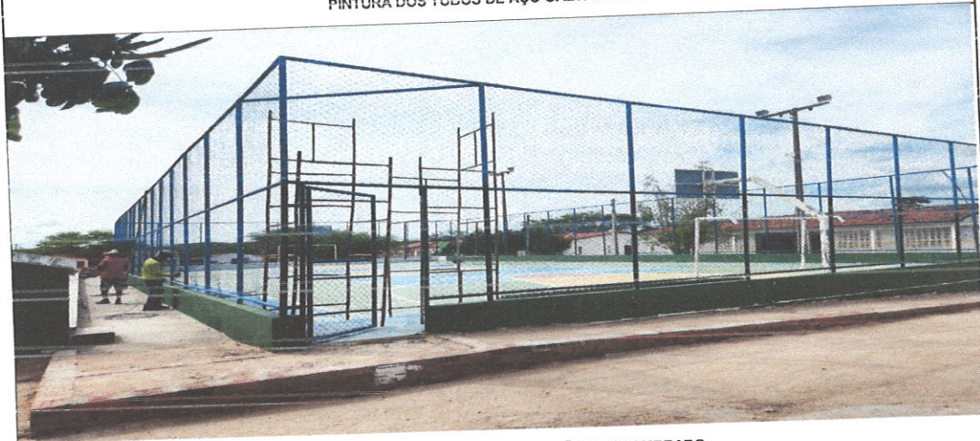
APLICAÇÃO DE SELADOR E EXECUÇÃO DE ALAMBRADO
